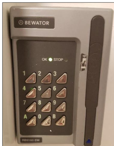
Bild 13: Ok att gå in! Dörren är öppen och din tagg är validerad.
