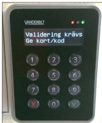
Bild 9: Vid avlarmning krävs, förutom bricka, även personlig kod.
