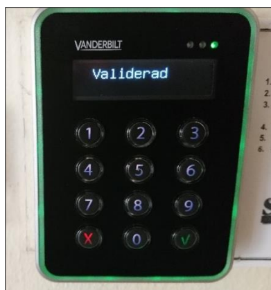
Bild 10: Ok att gå in! Zonen är avlarmad.
