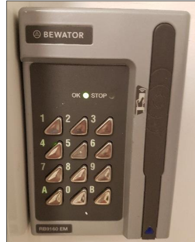
Bild 8: Ok att gå in! Dörren är öppen och din tagg är validerad.
